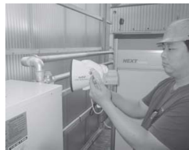
図-5 エア漏れチェック
