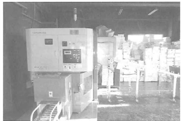
函館市水産物地方卸売市場
