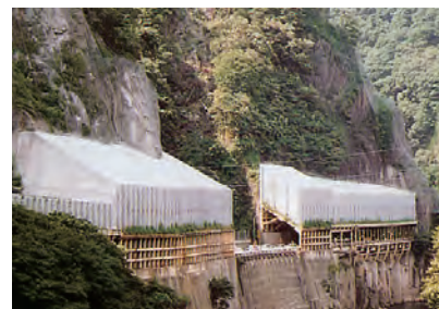
落石の衝撃を弱めるために、ロックシッドの上に積み上げたEPSブロック。
