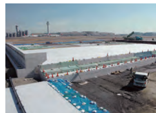
道路資材(EPS土木工法)
