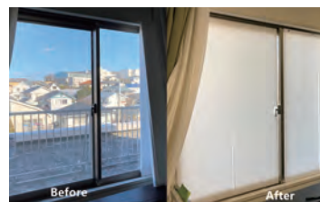
着脱式EPS窓断熱改修工法(開発中)
